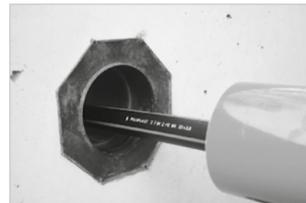
**2.** Mediumleitung durch das Setzungsschutzrohr und das Lamellenrohr schieben.
