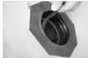
**1.** Gebäudeaußenseitig Lippendichtringe in die zwei Sicken des Lamellenrohrs einlegen.
