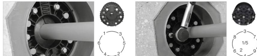
**5. Dichtelemente mit Verpressindikatoren:** Sobald alle gelben Verpressindikatoren aus dem Flansch herausgedrückt sind, Schrauben mittels Drehmomentschlüssel auf 6 Nm anziehen.
