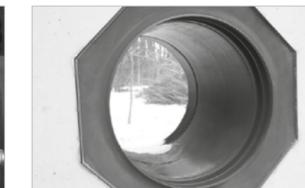
**6.** POLO-RDS Evolution Lamellenrohr fertig einbetoniert.
