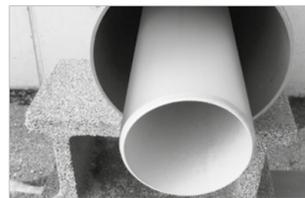
**6.** Für Kanalrohr DN 160 bzw. 200 verwenden Sie ein Setzungsschutzrohr DN  $\geq$  250, für Mediumleitung 250 mm verwenden Sie ein Setzungsschutzrohr  $\geq$  DN 315; Auflager im Bereich der Kelleraußenwand herstellen.
