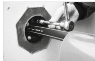
**4.** Schrauben in mehreren Durchgängen über Kreuz anziehen – Anzugsmoment 6 Nm.
