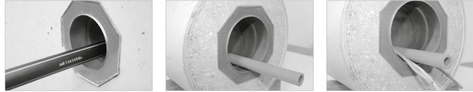
**1. Mediumleitung durch das einbetonierte Lamellenrohr schieben.**
