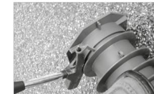
Das Lamellenrohr auf Wandstärken 20 cm oder 25 cm durch Abziehen der Abreißelemente kürzen.
