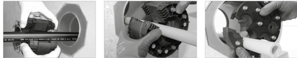
**3. Dichtelement über die Mediumleitungen klappen und bis zur Anschlagkante ins Lamellenrohr schieben.**
