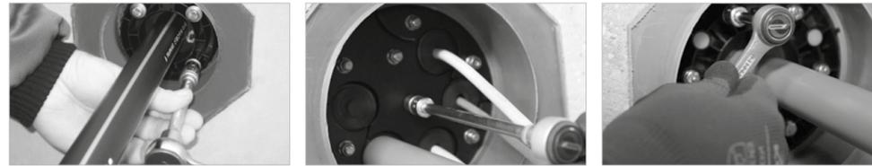
**4. Schrauben in mehreren Durchgängen über Kreuz anziehen.**
